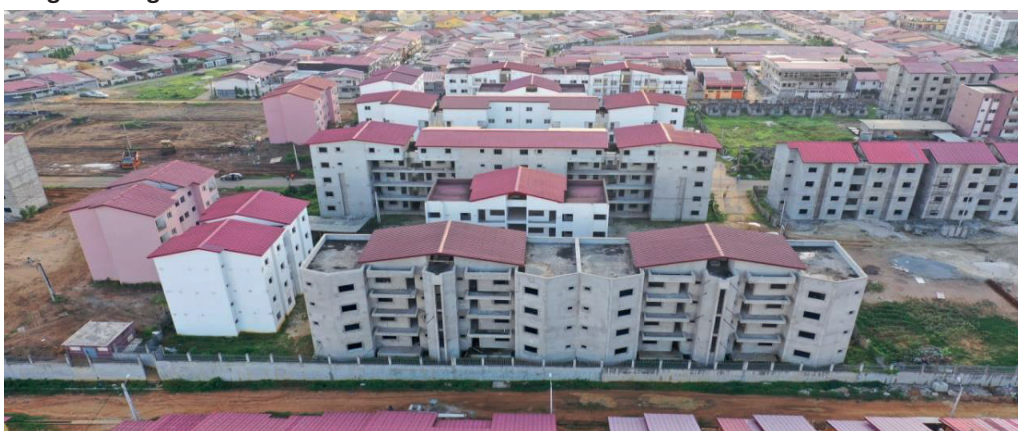
Image 3 : Programme Immobilier FPM LATRILLE
